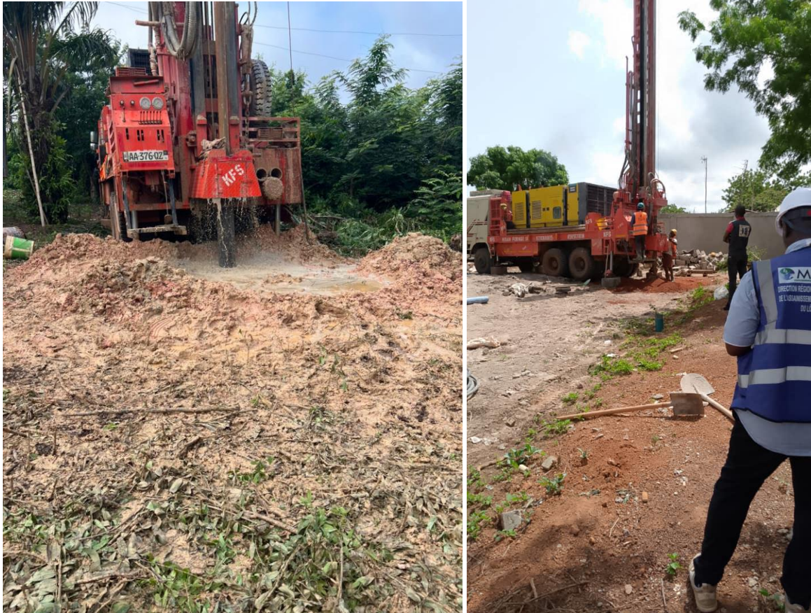
Réalisation de forage
